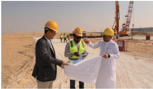
SPARK 산업단지 내에 들어설 SeAH GSI 공장 건설 현장
