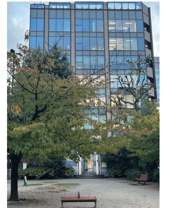
2023년 이전한 신규 사무실 빌딩 외관
